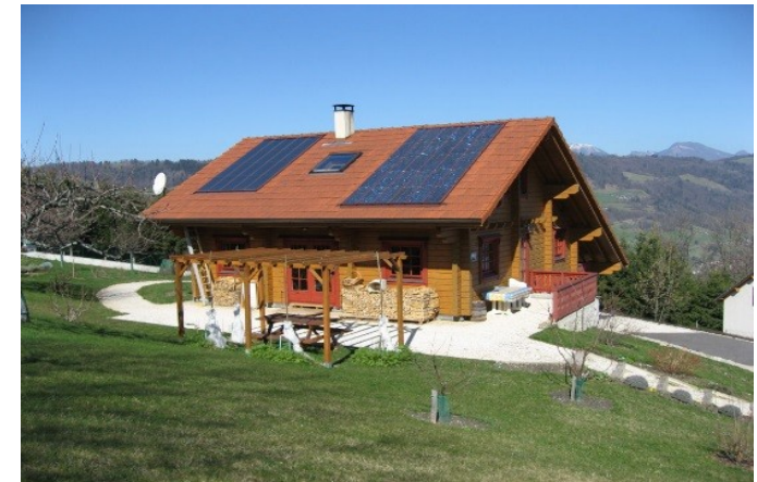
Le chauffage solaire
