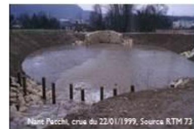
Nant Petchi, crue du 22/01/1999. Source RTM 73
